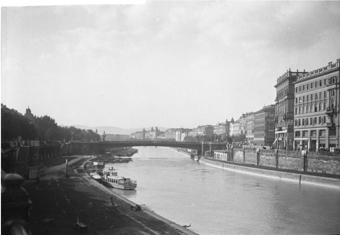
Abb. 12 Donaukanal um 1900, der Hafenquerschnitt ist an dieser Stelle realisiert worden
