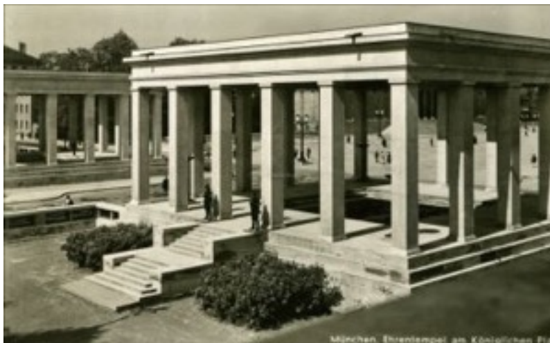
Abb. 6 Ehrentempel in München vor der Sprengung 1947
