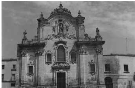
Abb.18 „S. Francesco Fassade“
