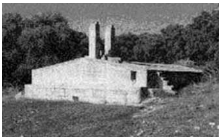
Abb.44 „cisterna a tetto“
